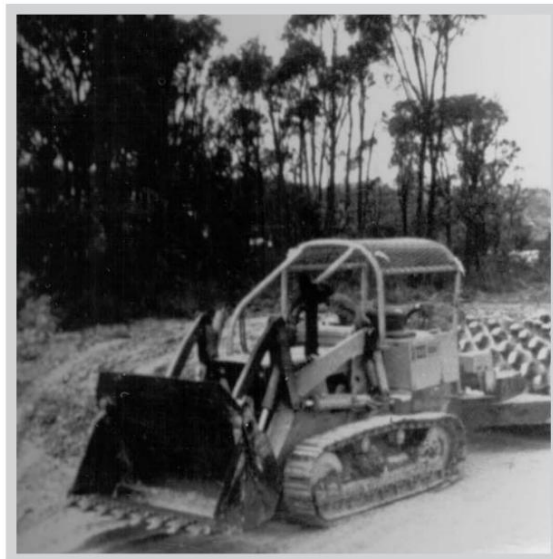
Những khó khăn trong việc xây dựng Trường học và Trung tâm Y tế Allambie trên địa điểm của một mỏ đá bỏ hoang. Nền móng cần được hỗ trợ trên các trụ trên đá rắn.
