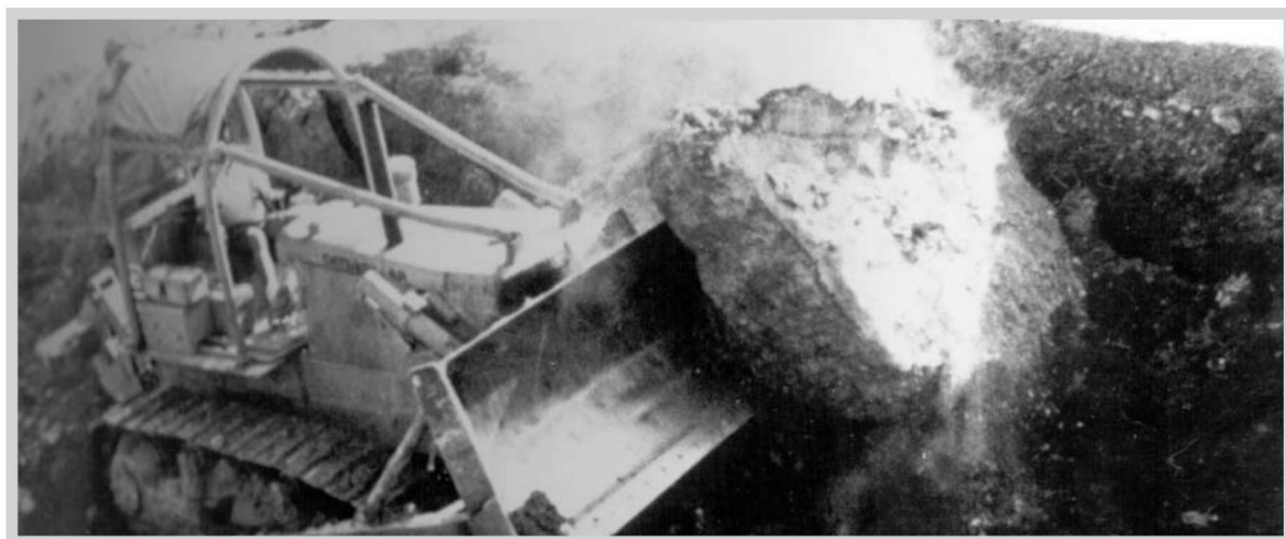
Những khó khăn trong việc xây dựng Trường học và Trung tâm Y tế Allambie trên địa điểm của một mỏ đá bỏ hoang. Nền móng cần được hỗ trợ trên các trụ trên đá rắn.
