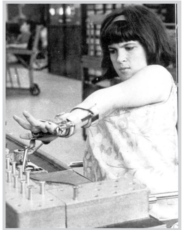
Carmella Kirkman đang lắp ráp lõi và má bằng máy ép tự động. Lưu ý rằng thanh nẹp tay cung cấp một ngã ba cho bộ phận cấu thành.
